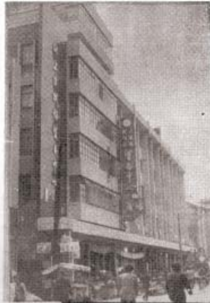
△ 县供销贸易中心暨桃园商场
